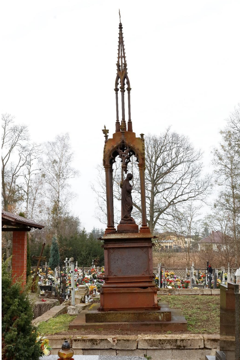
Fot. 35 Cmentarz parafialny w Skrwilnie. Kwatera grobowa rodziny Chełmickich. Nagrobek Kunegundy z Lasockich Mioduskiej. Widok ogólny od wschodu. Całość silnie skorodowana, na szorstkiej i porowatej powierzchni żeliwa bytują kolonie mikroorganizmów. Nagrobek w formie smukłej kapliczki wychylony, elementy cokołu spięte skręconymi obejmami, w płytach cokołu ubytki. Widoczne braki kwiatonów wieńczących ośle łuki baldachimu
