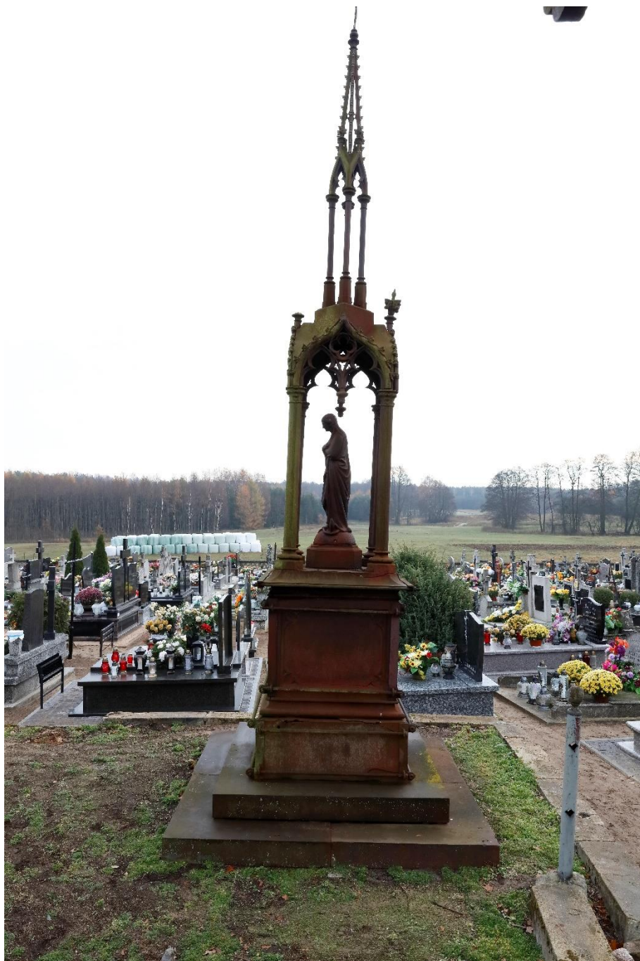
Fot. 33 Cmentarz parafialny w Skrwilnie. Kwatera grobowa rodziny Chełmickich. Nagrobek Kunegundy z Lasockich Mioduskiej. Widok ogólny od zach. Całość silnie skorodowana, na szorstkiej i porowatej powierzchni żeliwa bytują kolonie mikroorganizmów. Nagrobek w formie smukłej kapliczki wychylony, widoczne ubytki kwiatonów wieńczących ośle łuki baldachimu
