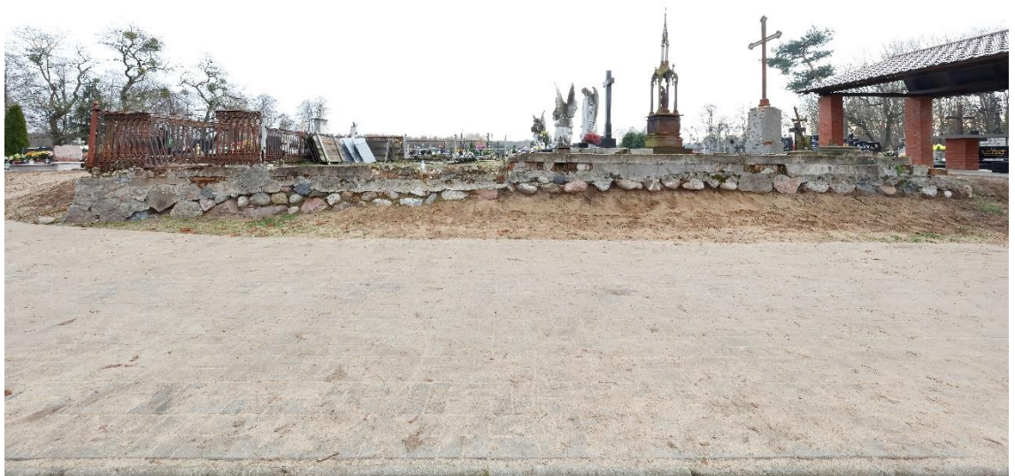
Fot. 2 Cmentarz parafialny w Skrwilnie. Kwaterna grobowa rodziny Chełmickich. Widok ogólny od zachodu. Widoczna zdegradowana konstrukcja muru oporowego, pełniącego jednocześnie rolę podwaliny pod ogrodzenie, zachowane szczątkowo. Fundament muru ułożony był w kilku warstwach z kamieni polnych, na nim ułożono warstwę wyrównawczą z cegieł i wylano betonową podwalinę
