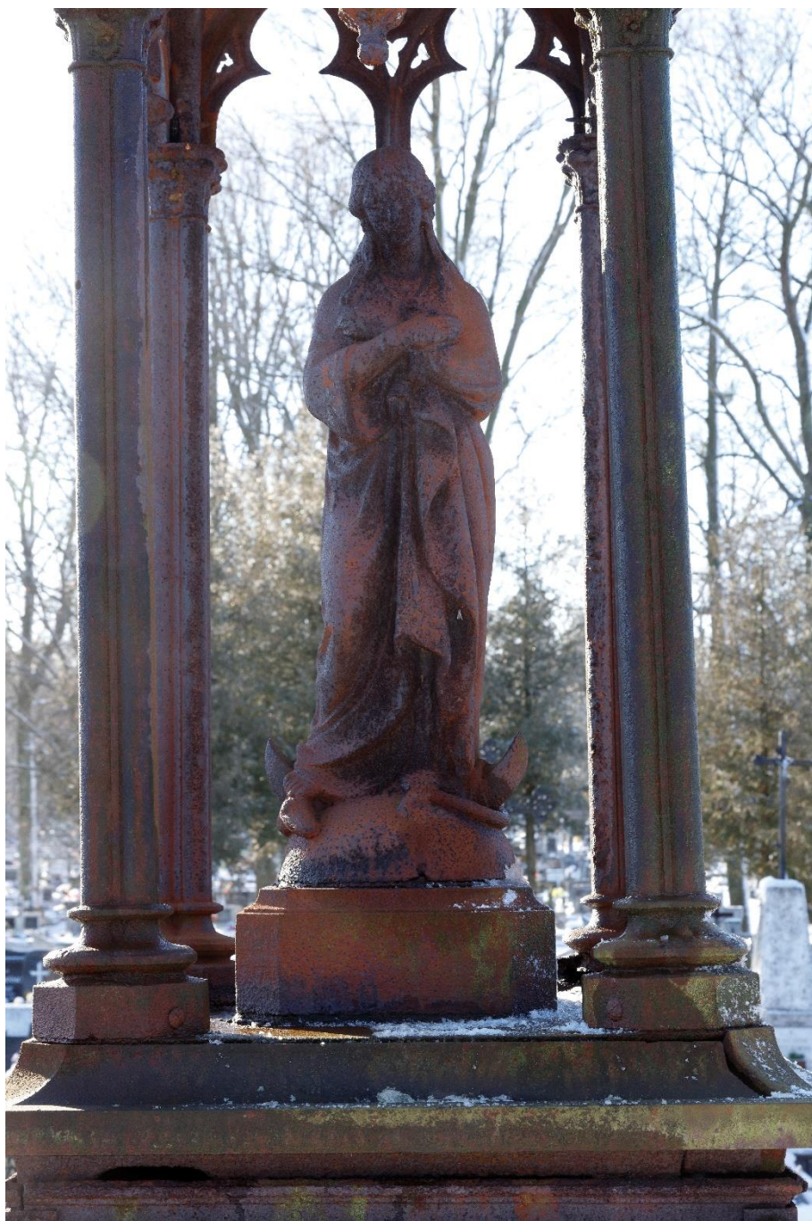
Fot. 37 Cmentarz parafialny w Skrwilnie. Kwatera grobowa rodziny Chełmickich. Nagrobek Kunegundy z Lasockich Mioduskiej. Widok figury MB Niepokalanej. Figura silnie skorodowana, na szorstkiej i porowatej powierzchni żeliwa bytują kolonie mikroorganizmów. Widoczne pęknięcia i przemieszczenia składowych elementów podstawy pod rzeźbę i baldachim
