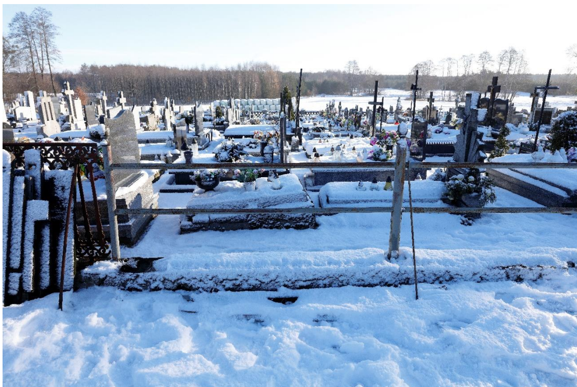
Fot. 47 Cmentarz parafialny w Skrwilnie. Kwaterna grobowa rodziny Chełmickich. Widok styku żeliwnego ogrodzenia z wtórnym ogrodzeniem stalowym wzdłuż wschodniej granicy kwatery
