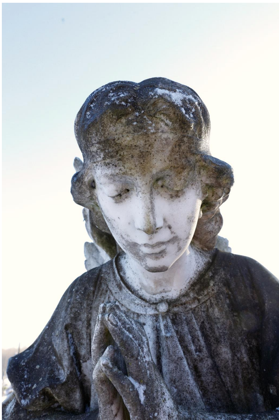
Fot. 22 Cmentarz parafialny w Skrwilnie. Kwatera grobowa rodziny Chełmickich. Postać Anioła Modlitwy, strona wsch. kompozycji, widok od zach., fragment. Powierzchnia marmuru szorstka i matowa, poszarzała, pokryta koloniami mikroorganizmów i nawarstwieniami typu atmosferycznego – najbardziej intensywnie w partii włosów, skrzydeł, ramion i rąk postaci. Szczegóły modelunku włosów ujętych w opaskę zmiękczone i nieco zatarte z powodu destrukcji powierzchni marmuru trawionej produktami metabolizmu mikroorganizmów, a następnie wymywanej przez wodę opadową
