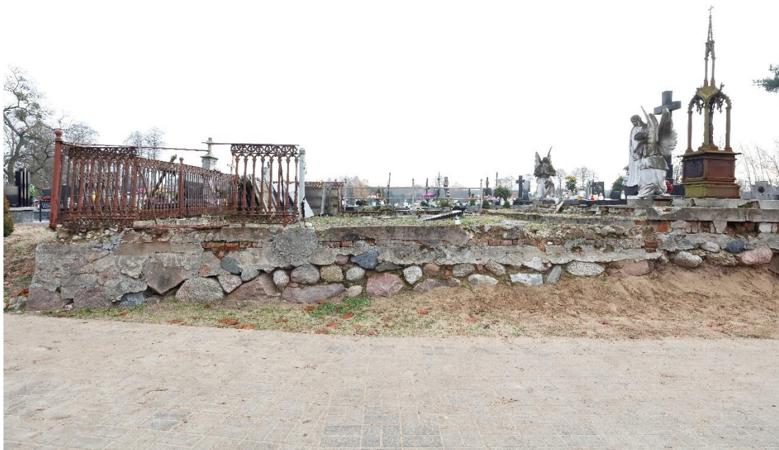
Fot. 3 Cmentarz parafialny w Skrwilnie. Kwaterna grobowa rodziny Chełmickich. Widok ogólny od zach., odcinek płn. - zach. Widoczna zdegradowana konstrukcja muru oporowego, pełniącego jednocześnie rolę podwaliny pod ogrodzenie, zachowane szczątkowo. Fundament muru ułożony był w kilku warstwach z kamieni polnych, na nim ułożono warstwę wyrównawczą z cegieł i wylano betonową podwalinę
