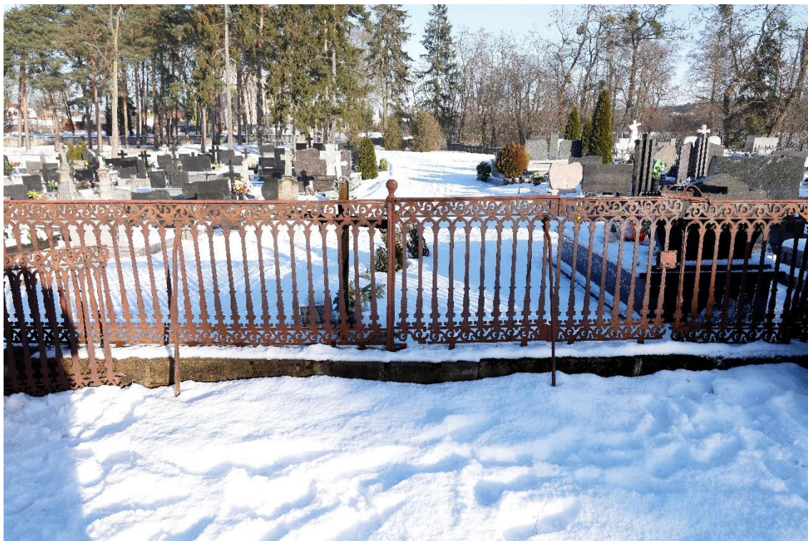
Fot. 46 Cmentarz parafialny w Skrwilnie. Kwaterna grobowa rodziny Chełmickich. Widok żeliwnego ogrodzenia w kierunku półn. Fragment z zachowanym dawnym wejściem. Całość skorodowana
