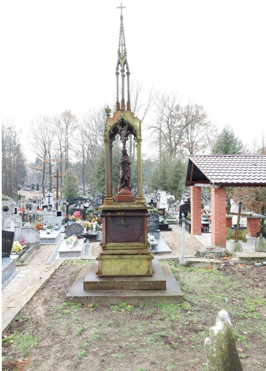
Fot. 32 Cmentarz parafialny w Skrwilnie. Kwatera grobowa rodziny Chełmickich. Nagrobek Kunegundy z Lasockich Mioduskiej. Widok ogólny od płu. Całość silnie skorodowana, na szorstkiej i porowatej powierzchni żeliwa bytują kolonie mikroorganizmów. Nagrobek w formie smukłej kapliczki wychylony, widoczne ubytki kwiatonów wieńczących osie łuki baldachimu
