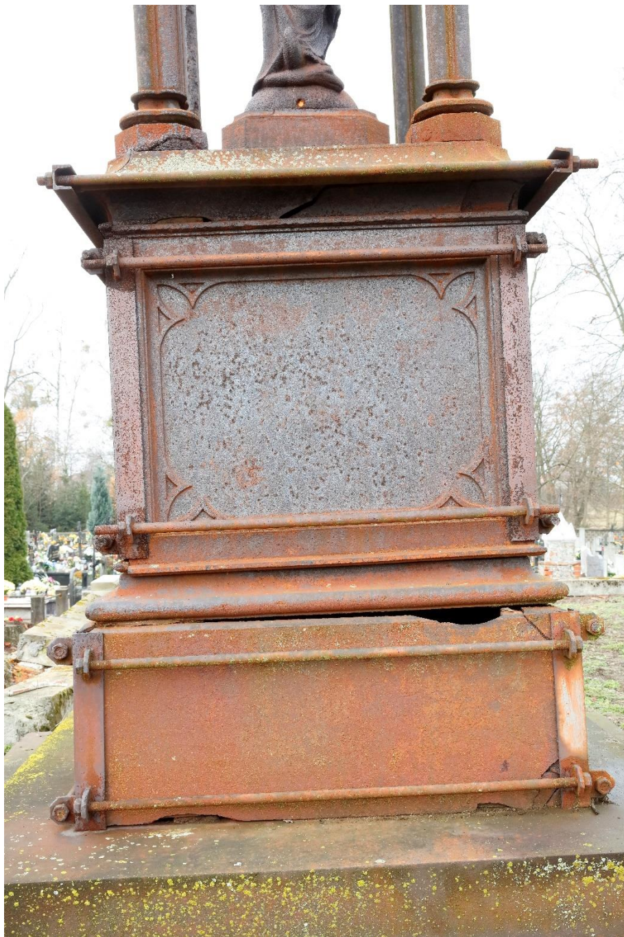
Fot. 43 Cmentarz parafialny w Skrwilnie. Kwatera grobowa rodziny Chełmickich. Nagrobek Kunegundy z Lasockich Mioduskiej. Fragment cokołu, ściana wsch. Elementy cokołu spięte skręconymi obejmami, silnie spękanymi, z ubytkami. Powierzchnia skorodowana i pokryta skupiskami kolonii mikroorganizmów
