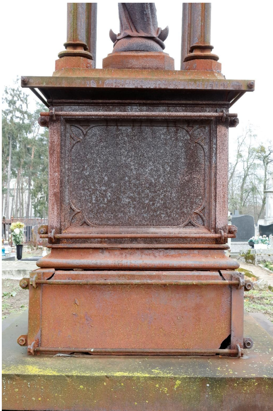
Fot. 42 Cmentarz parafialny w Skrwilnie. Kwatera grobowa rodziny Chełmickich. Nagrobek Kunegundy z Lasockich Mioduskiej. Fragment cokołu, ściana płd. Elementy cokołu spięte skręconymi obejmami, silnie spękane, z ubytkami. Powierzchnia skorodowana i pokryta grubą warstwą kolonii mikroorganizmów
