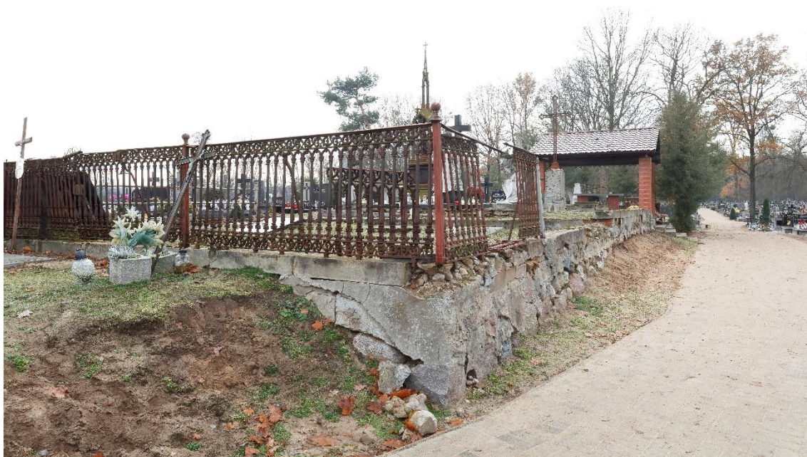
Fot. 4 Cmentarz parafialny w Skrwilnie. Kwaterna grobowa rodziny Chełmickich. Widok ogólny od płn.-zach. Widoczna zdegradowana konstrukcja muru oporowego, pełniącego jednocześnie rolę podwaliny pod ogrodzenie, po stronie północnej zachowane w całości razem z furtką. Fundament muru ułożony był w kilku warstwach z kamieni polnych, na nim ułożono warstwę wyrównawczą z cegieł i wylano betonową podwalinę. Żeliwne, obecnie silnie skorodowane przęsła zaopatrzone we wsporniki, które wpuszczone są w betonową podwalinę
