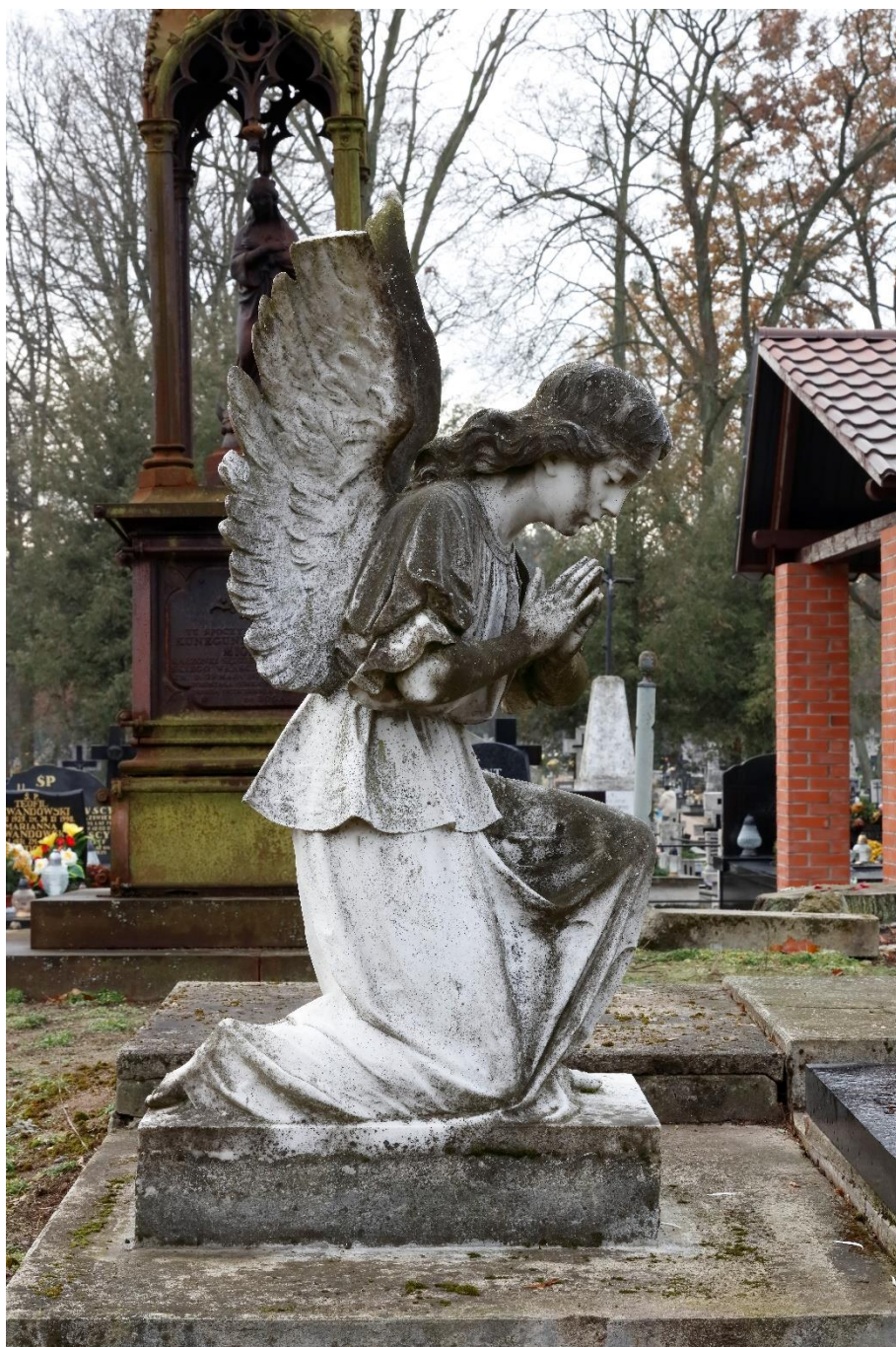
Fot. 17 Cmentarz parafialny w Skrwilnie. Kwatera grobowa rodziny Chełmickich. Postać Anioła Modlitwy, strona wschodnia kompozycji, widok od płu. Powierzchnia marmuru szorstka i matowa, poszarzała, pokryta koloniami mikroorganizmów i nawarstwieniami typu atmosferycznego – najbardziej intensywnie w partii głowy, skrzydeł, ramion, rąk postaci oraz na udzie ugiętej nogi i podstawie rzeźby. Widoczny znaczny ubytek końcówki skrzydła
