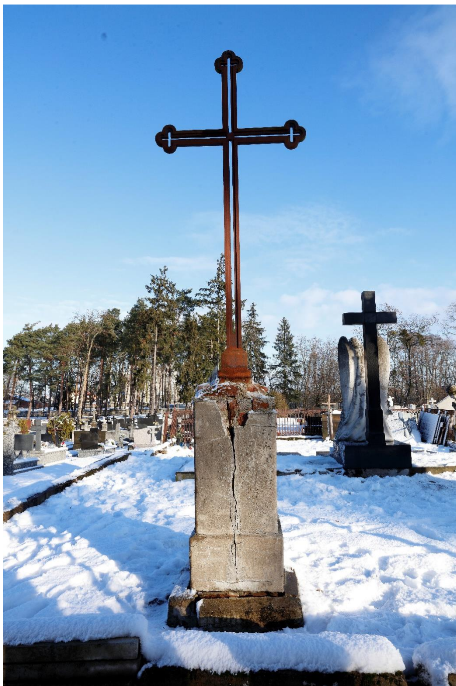
Fot. 45 Cmentarz parafialny w Skrwilnie. Kwatera grobowa rodziny Chełmickich. Nagrobek Korduli z Lasockich Chełmickiej, Anny z Mioduskich Karnkowskiej, Ignacego Chełmickiego w formie krzyża. Widok od pld. Żelwny krzyż skorodowany, jego trzpień rozsadził ceglany cokół powodując pionowe pęknięcie przez całą wysokość cokołu. Betonowy tynk odspojony odpada od ceglanoego trzonu
