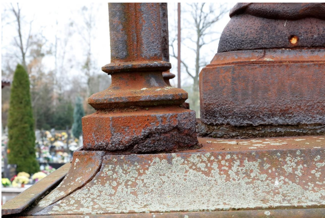
Fot. 39 Cmentarz parafialny w Skrwilnie. Kwatera grobowa rodziny Chełmickich. Nagrobek Kunegundy z Lasockich Mioduskiej. Fragment bazy kolumny baldachimu – całkowicie skorodowanej, z wżerami i ubytkami oraz poważnymi pęknięciami. Na powierzchni żeliwa bytują mikroorganizmy
