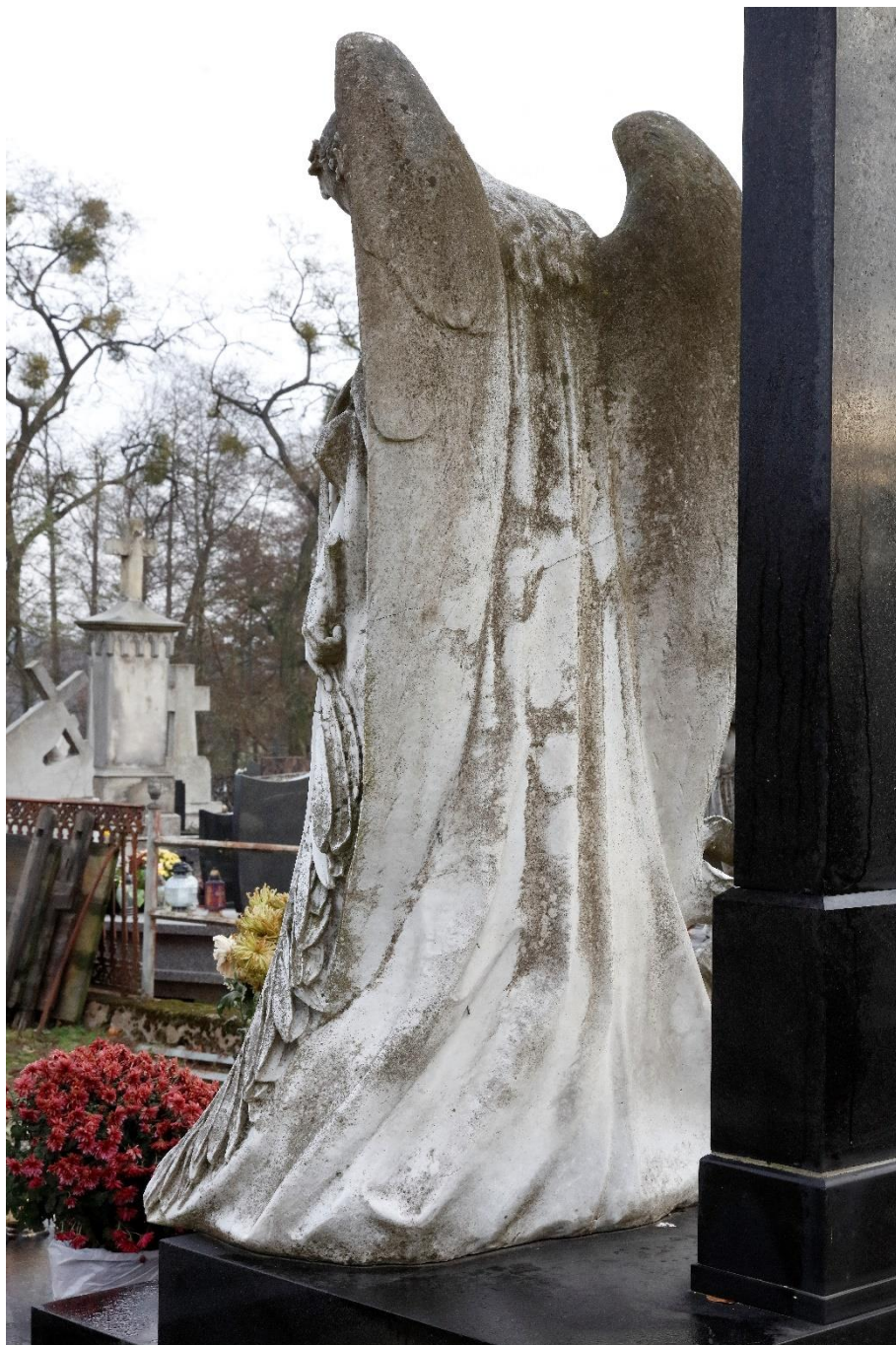
Fot. 8 Cmentarz parafialny w Skrwilnie. Kwatera grobowa rodziny Chełmickich. Postać Anioła Smutku, widok od strony pód. - zach. Powierzchnia marmuru szorstka i matowa, poszarzała, pokryta koloniami mikroorganizmów i nawarstwieniami typu atmosferycznego – najbardziej intensywnie w partii skrzydeł. Widoczne zarysowania kamienia w środkowej partii pleców, w poprzek fałd szaty. Krzyż i podstawa z ciemnego, polerowanego kamienia w stanie dobrym
