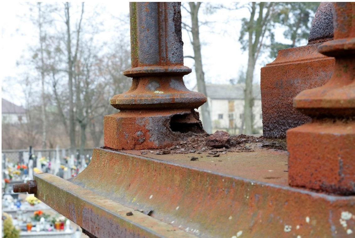
Fot. 38 Cmentarz parafialny w Skrwilnie. Kwatera grobowa rodziny Chełmickich. Nagrobek Kunegundy z Lasockich Mioduskiej. Fragment bazy kolumny baldachimu – całkowicie skorodowanej, z wżerami i ubytkami
