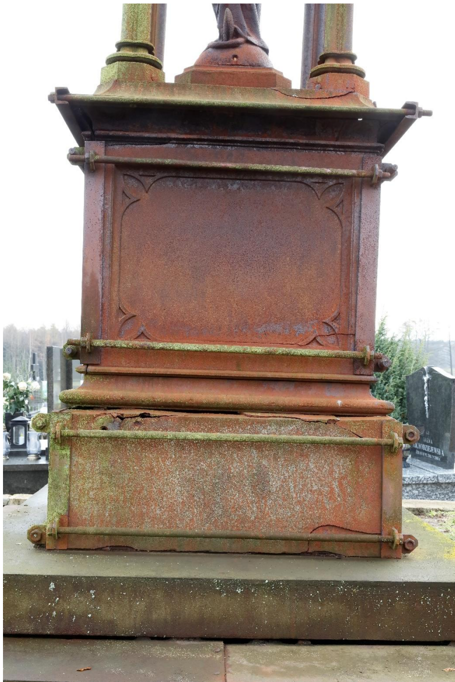
Fot. 41 Cmentarz parafialny w Skrwilnie. Kwatera grobowa rodziny Chełmickich. Nagrobek Kunegundy z Lasockich Mioduskiej. Fragment cokołu, ściana zach. Elementy cokołu spięte skręconymi obejmami, silnie spękanie. Powierzchnia skorodowana i pokryta grubą warstwą kolonii mikroorganizmów. Widoczne wyraźne wychylenie kapliczki oraz szczelina pomiędzy stopniami podstawy
