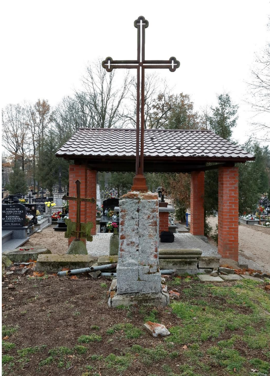
Fot. 44 Cmentarz parafialny w Skrwilnie. Kwatera grobowa rodziny Chełmickich. Nagrobek Korduli z Lasockich Chełmickiej, Anny z Mioduskich Karnkowskiej, Ignacego Chełmickiego w formie krzyża. Widok od płn. Żelwny krzyż skorodowany, jego trzpień rozsadził ceglany cokół powodując pionowe pęknięcie przez całą wysokość cokołu. Brak tablicy inskrypcyjnej
