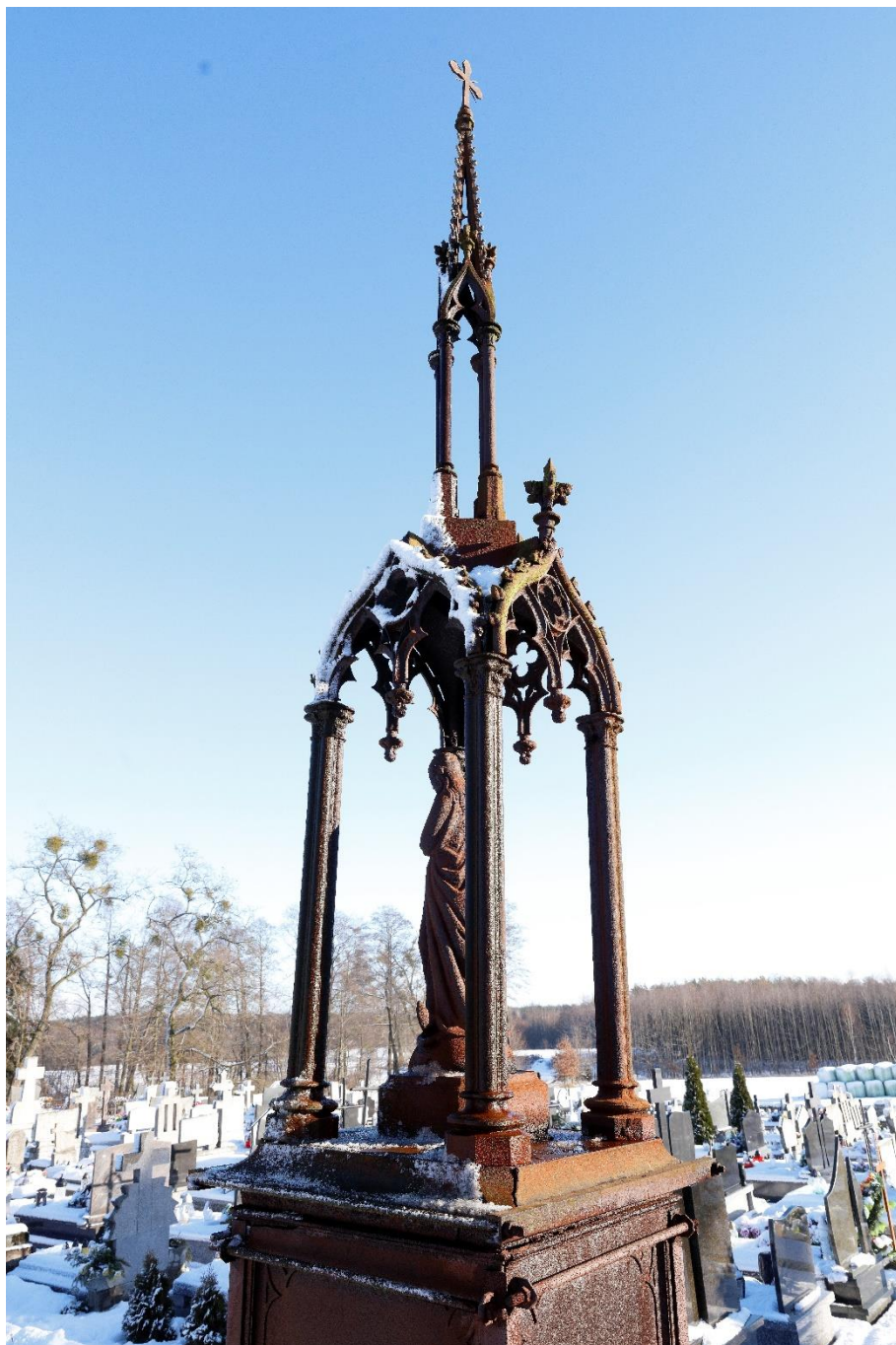
Fot. 36 Cmentarz parafialny w Skrwilnie. Kwatera grobowa rodziny Chełmickich. Nagrobek Kunegundy z Lasockich Mioduskiej. Widok baldachimu zwieńczonego ażurową fialą od pld. – zach. Całość silnie skorodowana, na szorstkiej i porowatej powierzchni żeliwa bytują kolonie mikroorganizmów. Widoczne ubytki kwiatonów wieńczących ośle łuki baldachimu
