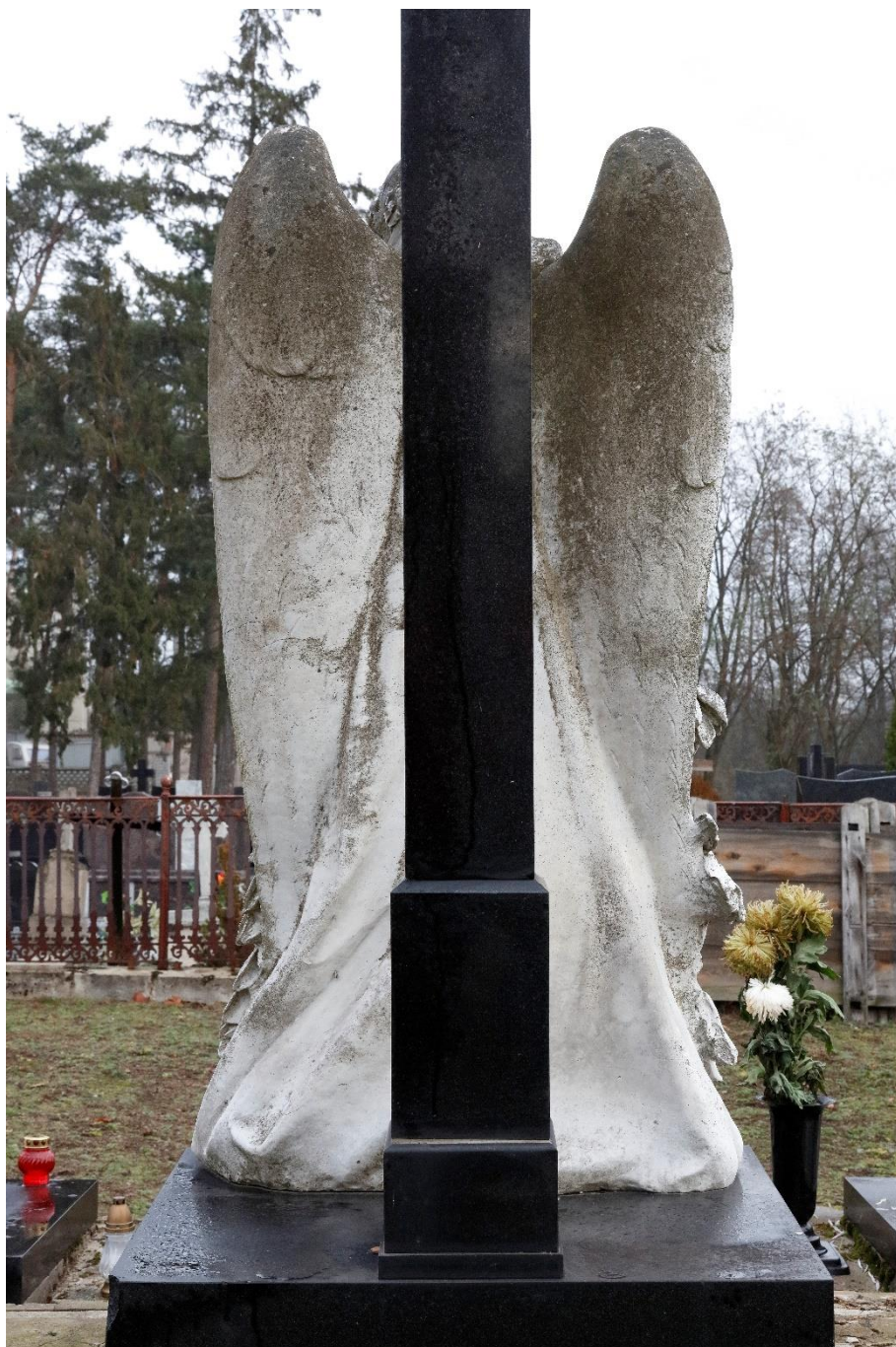
Fot. 9 Cmentarz parafialny w Skrwilnie. Kwaterna grobowa rodziny Chełmickich. Postać Anioła Smutku, widok od pld. Widoczny słup krzyża w stanie dobrym, wykonany z tego samego, polerowanego kamienia jak podstawa, również w stanie dobrym; widoczny odprysk górnego pld. – zach. narożnika podstawy
