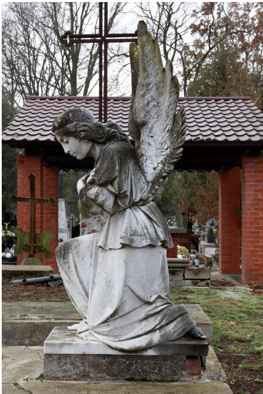
Fot. 23 Cmentarz parafialny w Skrwilnie. Kwatera grobowa rodziny Chełmickich. Postać Anioła Modlitwy, strona zach. kompozycji, widok od płu. Powierzchnia marmuru szorstka i matowa, poszarzała, pokryta koloniami mikroorganizmów i nawarstwieniami typu atmosferycznego – najbardziej intensywnie w partii włosów, skrzydeł, ramion, rąk postaci oraz na kolanie ugiętej i stopie klęczącej nogi oraz podstawie rzeźby
