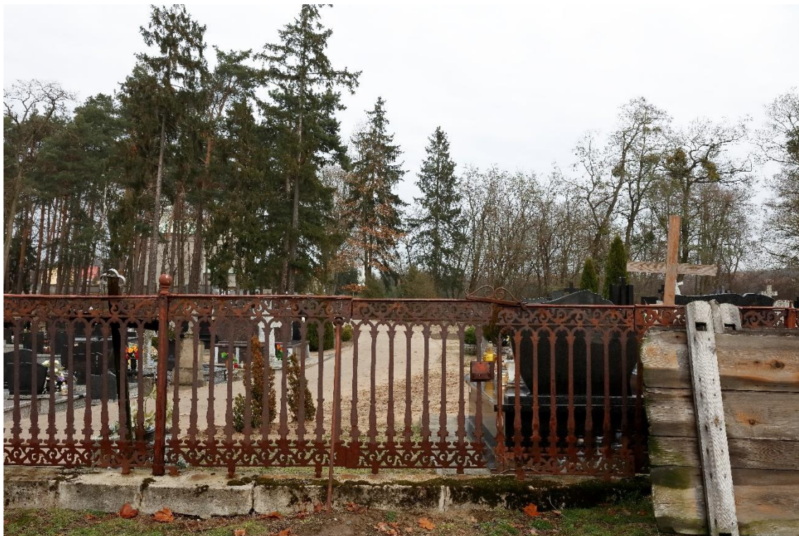
Fot. 48 Cmentarz parafialny w Skrwilnie. Kwatera grobowa rodziny Chełmickich. Widok żeliwnego ogrodzenia w kierunku płu. Fragment z zachowanym dawnym wejściem. Całość skorodowana. Widoczna betonowa podwalina
